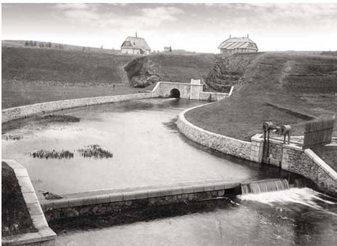
Obr. 37 Pohled na obtokový tunel Hamerské nádrže v roce 1912 (Muzeum Hlinsko)
