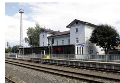
Obr. 157 Nádraží po rekonstrukci v roce 2018 (MAS Hlinecko)
