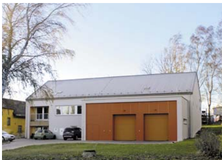
Obr. 150 Stanoviště rychlé záchranné služby v Hlinsku v ulici Poličská (MAS Hlinecko)
