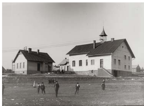
Obr. 162 Městská elektrárna roku 1908 (Muzeum Hlinsko)
