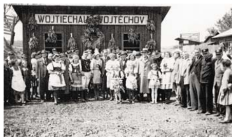
Obr. 158 Otevření železniční zastávky ve Vojtěchově v roce 1944 (Archiv obce Vojtěchov)
