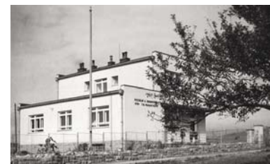
Obr. 151 Budovu bývalé Masarykovy ligy proti TBC nalezneme v sousedství Domova seniorů na Drachtinách (Muzeum Hlinsko)
