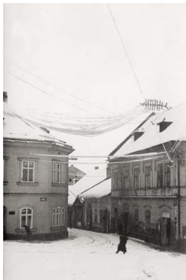
Obr. 29 Sněhem ohnuté stožáry telefonního a elektrického vedení (Muzeum Hlinsko)
