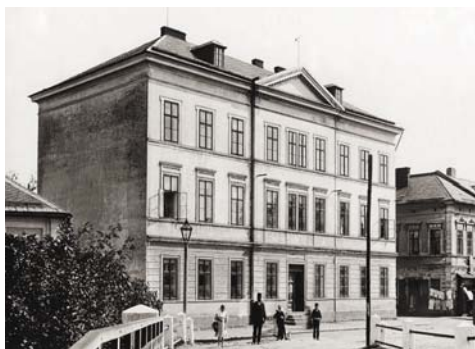
Obr. 144 Objekt bývalé měšťanské chlapecké školy, později obecné a měšťanské školy dívčí, ještě později ZŠ K. V. Raise a od roku 1984 hlineckého gymnázia. (Muzeum Hlinsko)
