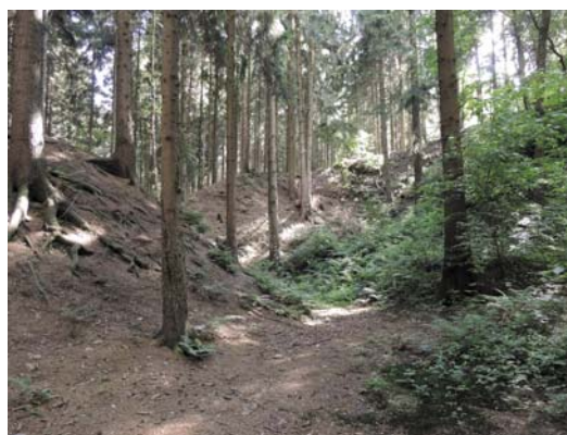
Obr. 21 Ve stěnovém lomu obce Kladno se těžily břidlice využívané například jako střešní krytina. (Marian Solčanský)
