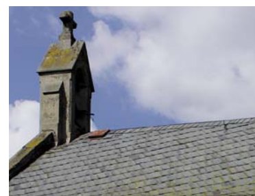
Obr. 22 Břidlicová střeška na kostele sv. Mikuláše v obci Vysočina (MAS Hlinecko)
