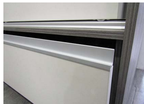
Hrany korpusu skříně a hrany zásuvek olepené nově pořízeným strojem
