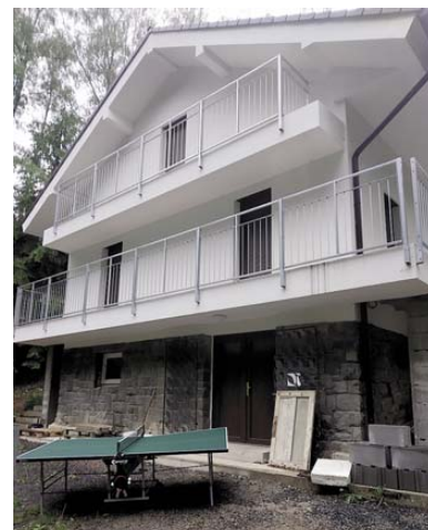
Foto po realizaci
